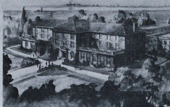
FIELD HOUSE AND RECREATION BLDG. L. S. U. BATON ROUGE LA.
